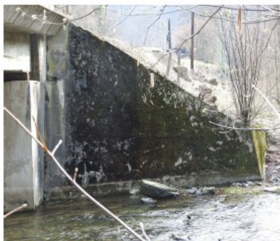
Foto č.8 - O 02 pravé křídlo, degradovaný beton
