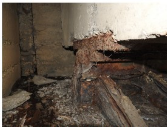
Foto č. 4 - K 01 - pravý nosník, pravé ložisko na O 01 korozní oslabení
