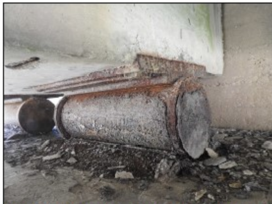
Foto č. 5 - K 01 - levý nosník, pravé ložisko na O 02 korozí částečně strávený návalek
