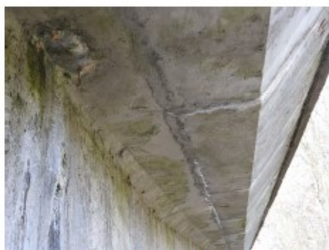
Foto č.2: K 01 Levý nosník, degradovaný beton ve střední části.
