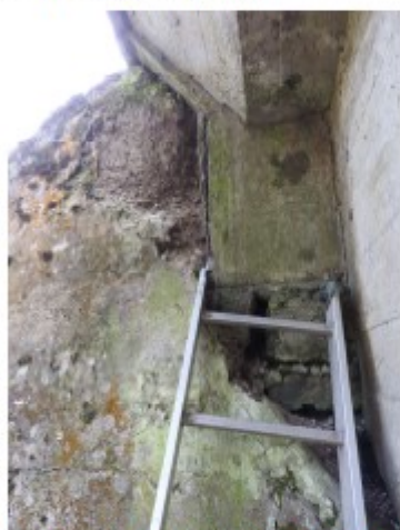
Foto č.7 - O 02 levé křídlo, degradovaný beton
