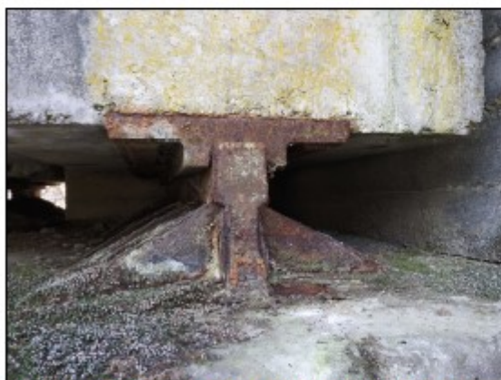
Foto č. 3 - K 01 - levý nosník, levé ložisko na O 01 korozní oslabení
