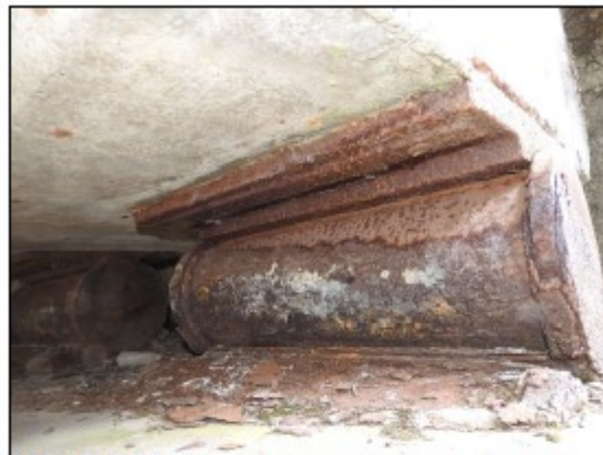
Foto č. 6 - K 01 - pravý nosník, rozpadající se válec pravého ložiska na O 02.
